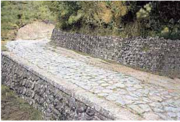
un tratto di via Popilia in provincia di Reggio Calabria
